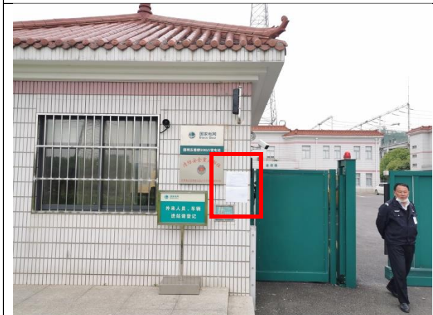
老东善桥变电站（远）
