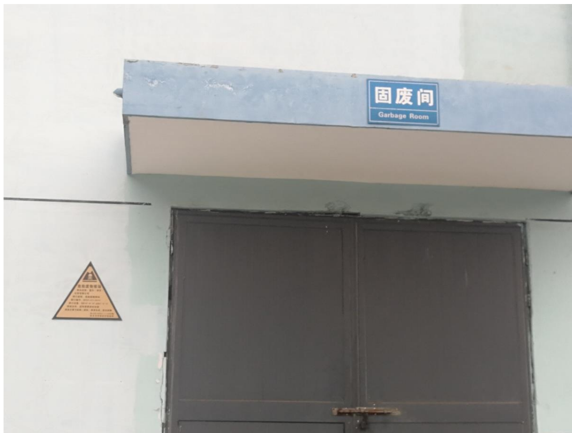
图 3.6-4 现有危废暂存库
