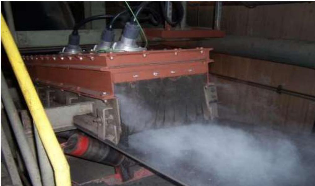
图 6.1-8 导料槽端部防尘帘及喷雾装置示例图
