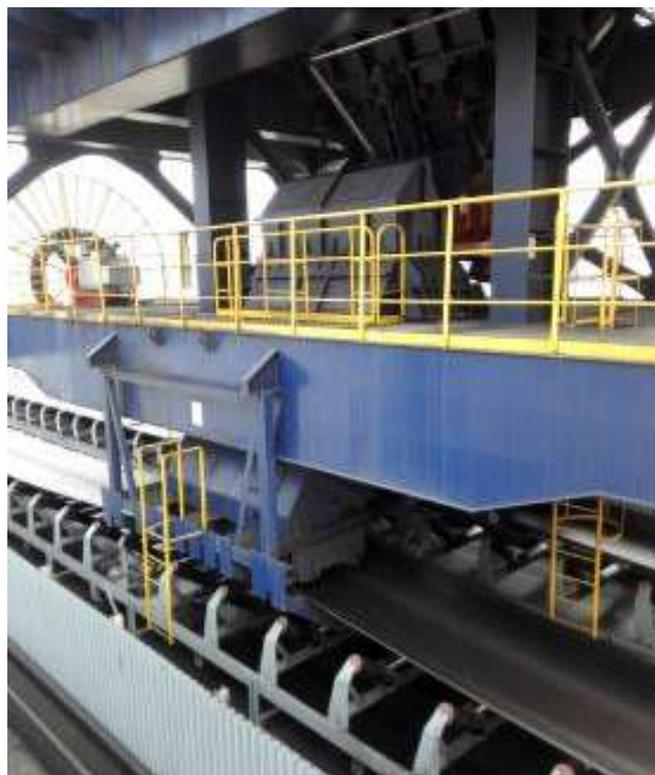
图 6.1-2 卸料漏斗下口防尘帘示例图
