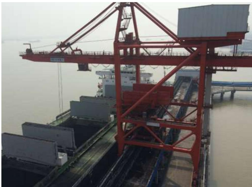
图 6.1-3 码头前沿段输送廊道挡风板示例图
