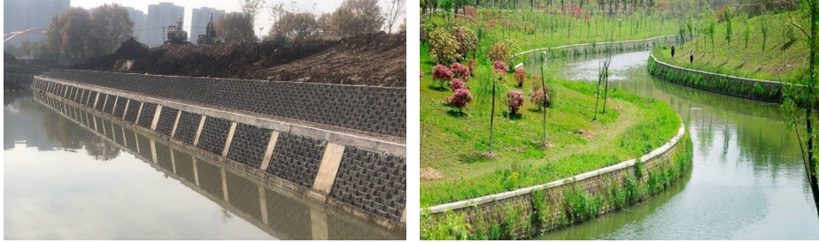
图 1-20 垂直挡墙型式样图
