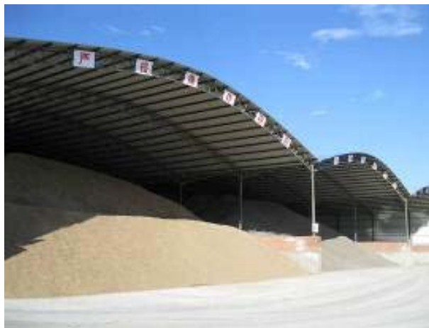
拌合站中砂、碎石密闭存放
