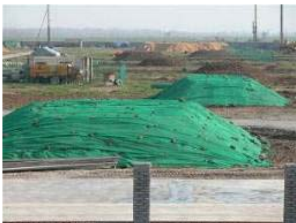
大临工程剥离表土苫盖
