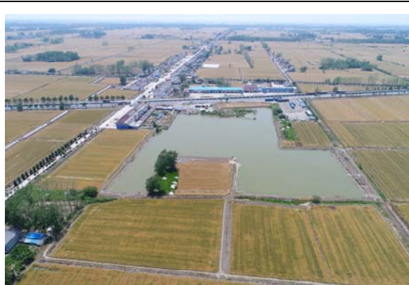
平桥镇 2 号弃土场
