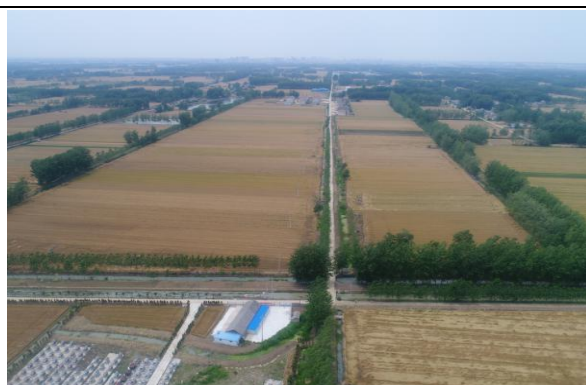
朱坝街道 1 号弃土场
