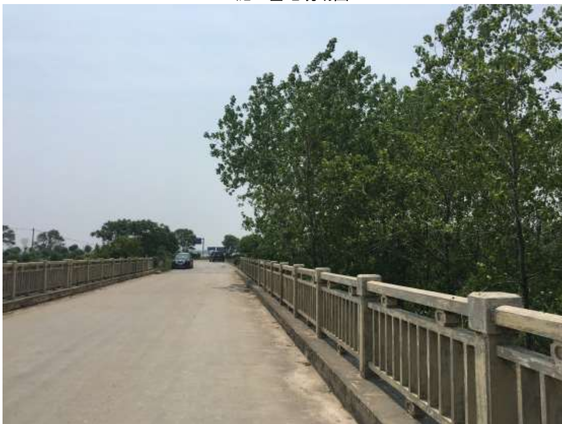
1#施工基地附近道路
