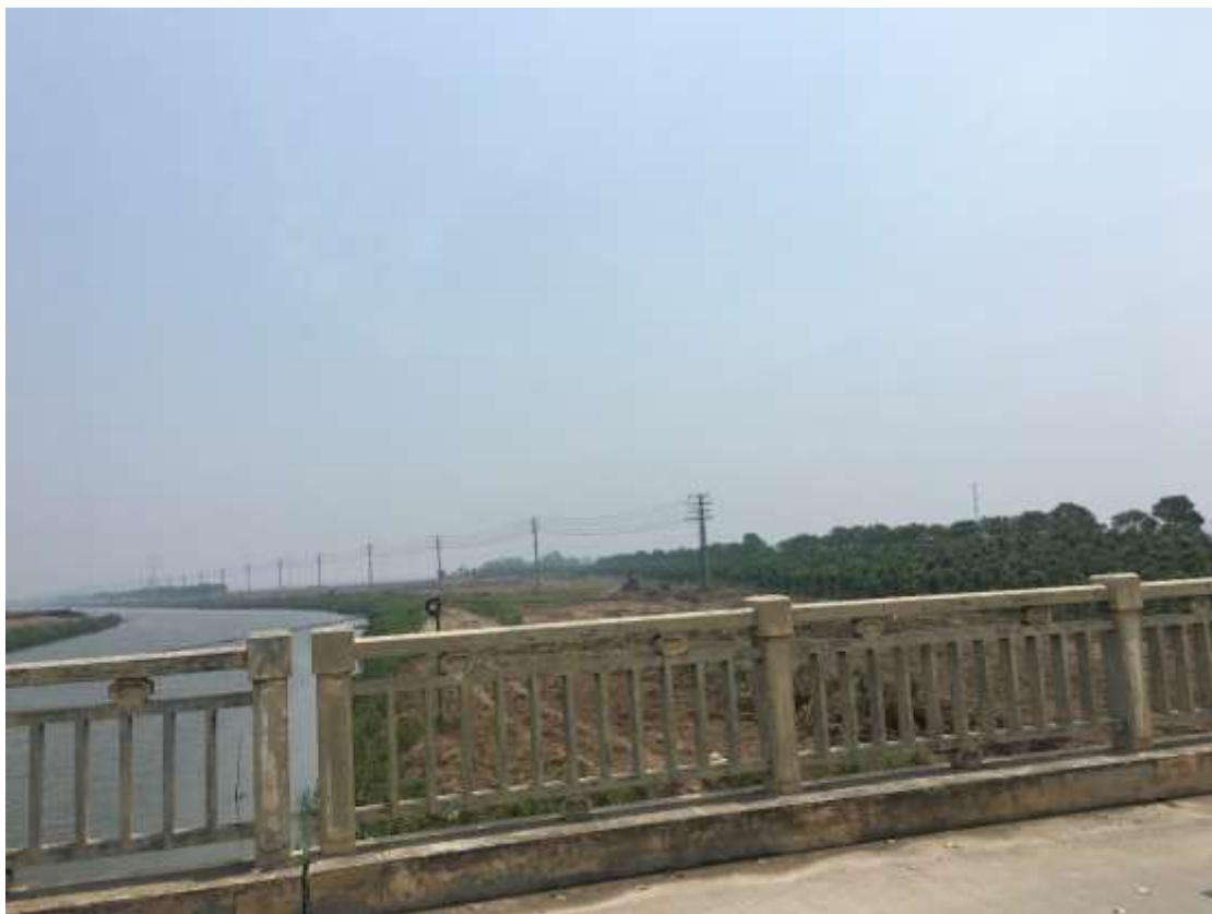
1#施工基地现场图
