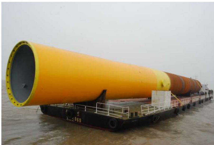
图 3.5-4 单桩钢管桩运输
