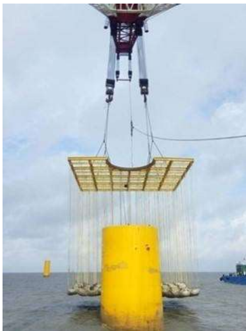
图 3.3-9 基础防冲刷保护
