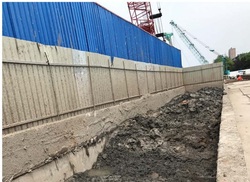
图 11.2.4-1 泥浆存放设施泥浆池
