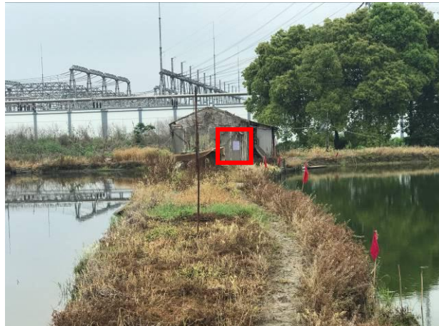
变电站西侧围墙外看护房 2
