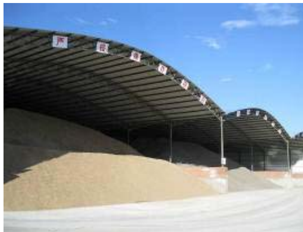
拌合站中砂、碎石密闭存放
