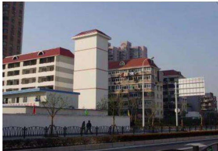
图 4-5-2 上海大连路风塔
