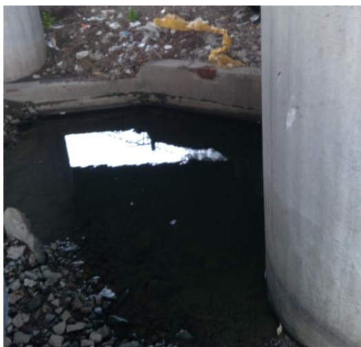
图9 撇洪沟5#排口现状
