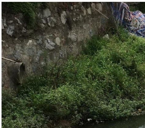
图7 撇洪沟3#排口现状
