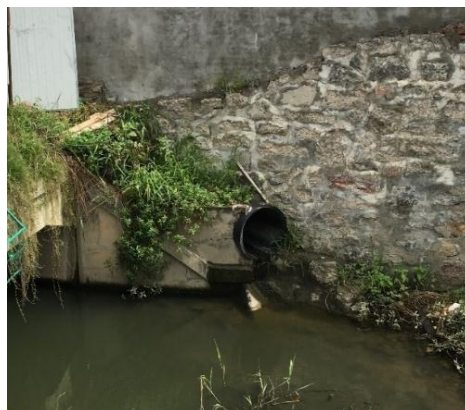
图8 撇洪沟4#排口现状
