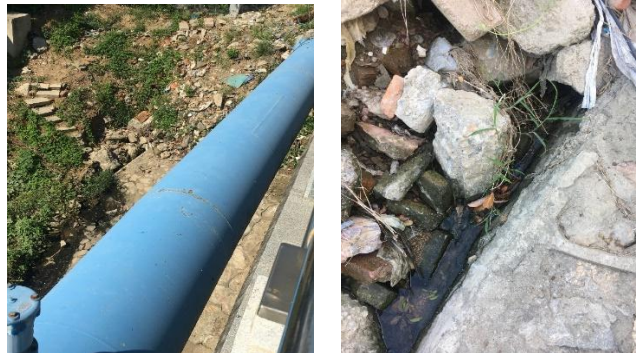
图5 撇洪沟1#排口现状
