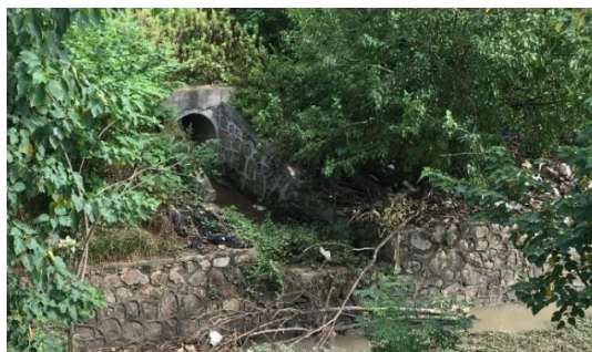
图6 撇洪沟2#排口现状
