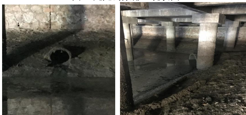
图 4 秦虹泵站进水渠现状图
