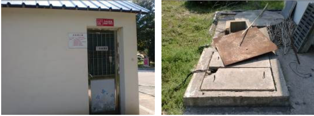
图 2.3-3 芙蓉服务区现有污水处理设施
