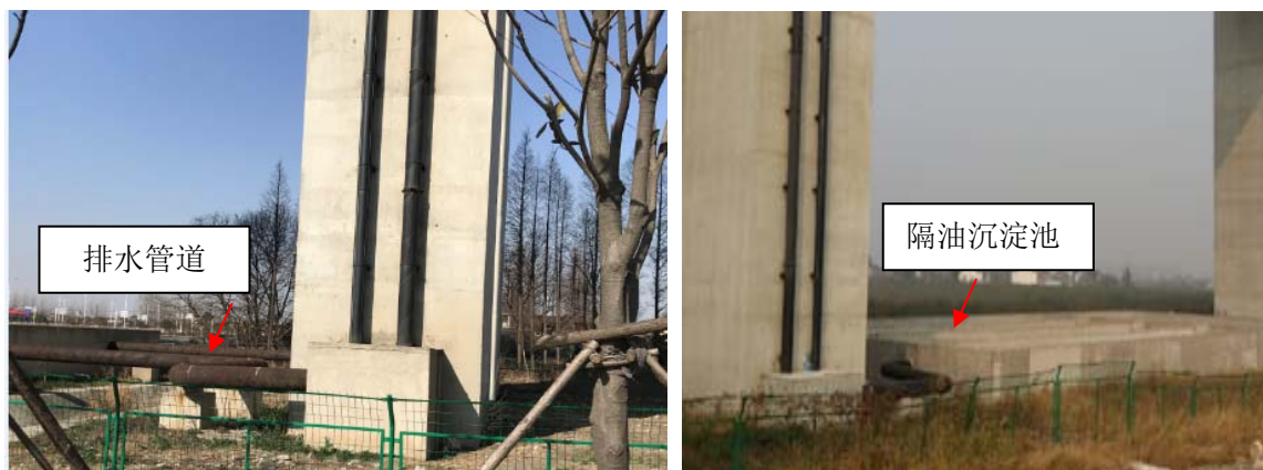
图6.3-7 泰州长江公路大桥跨江段桥面径流收集现场照片
