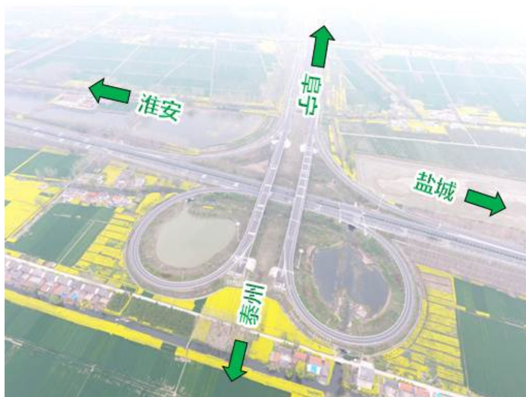
图 2.3-8 九龙口枢纽现状
