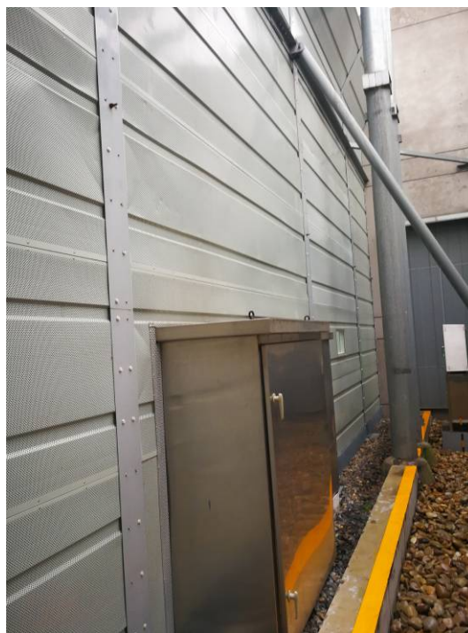
1#、2#主变压器之间防火墙内侧的吸声材料
