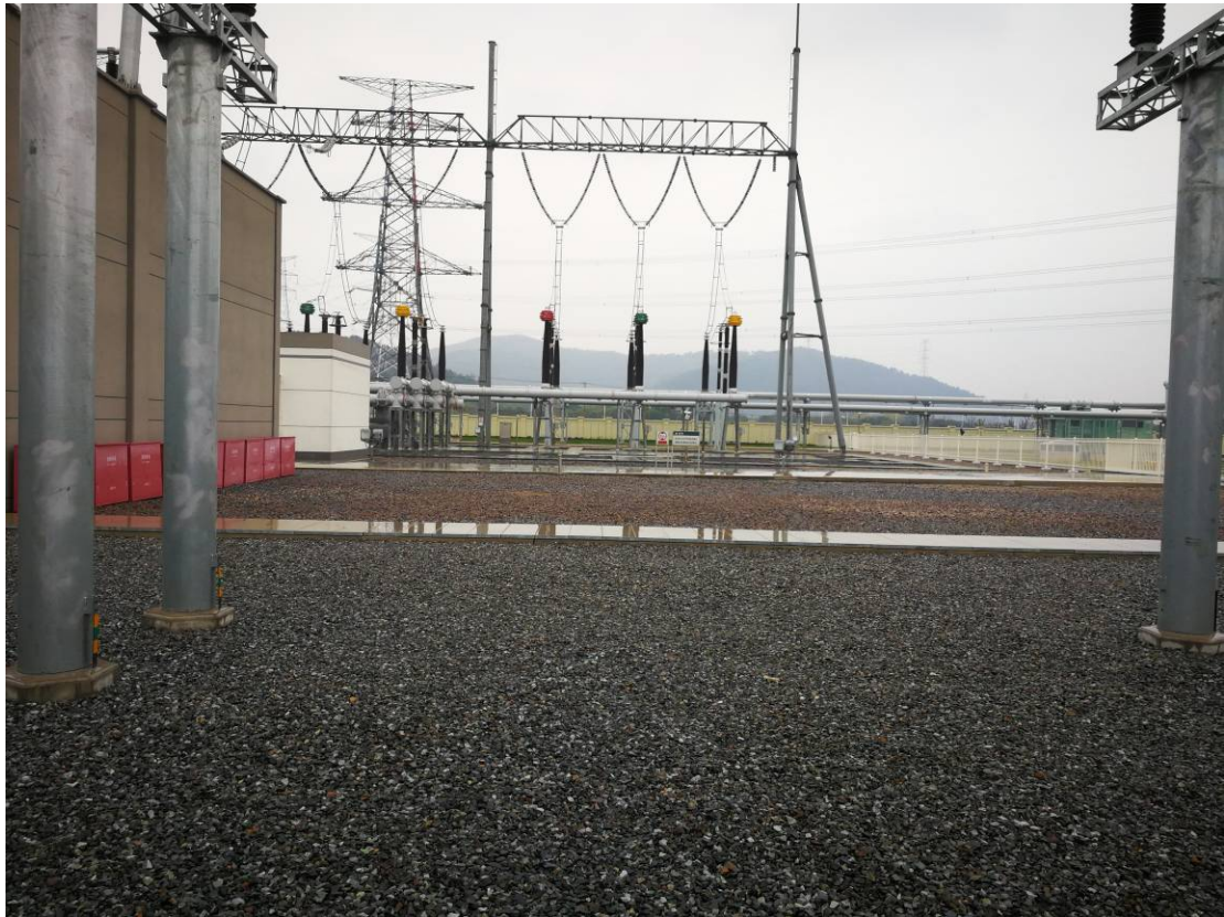
图 3.7 木渎 500kV 变电站 4#主变扩建位置
