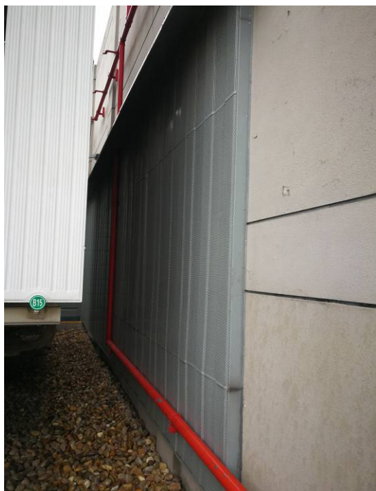
1#、2#主变压器之间防火墙内侧的吸声材料
