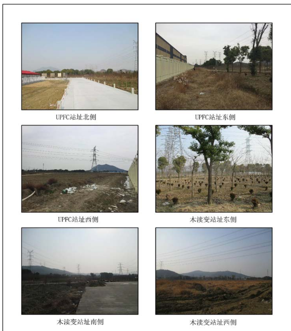
图3.3 木渎500kV变电站及UPFC站周围情况
