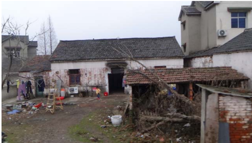
图 1 西寇村待拆迁房屋
