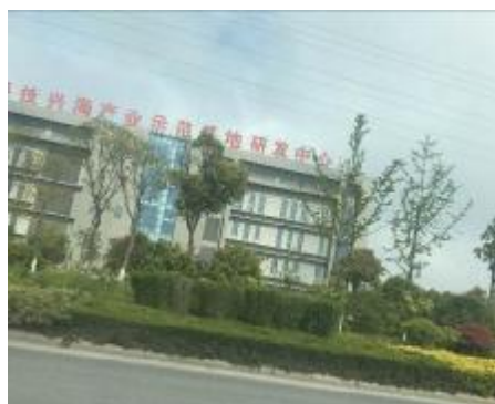
项目东北侧（国家科技兴海产业示范基地）
