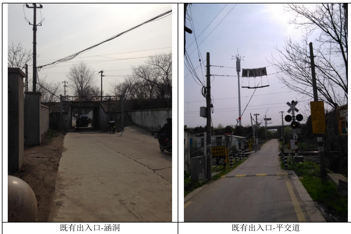
图 2.9-5 马家园车辆段选址场地内实景照片
