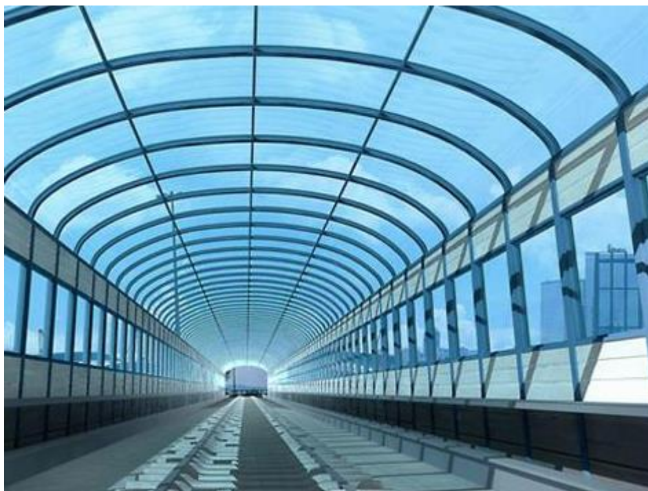
图 10.5.3-1 全封闭声屏障示意图
