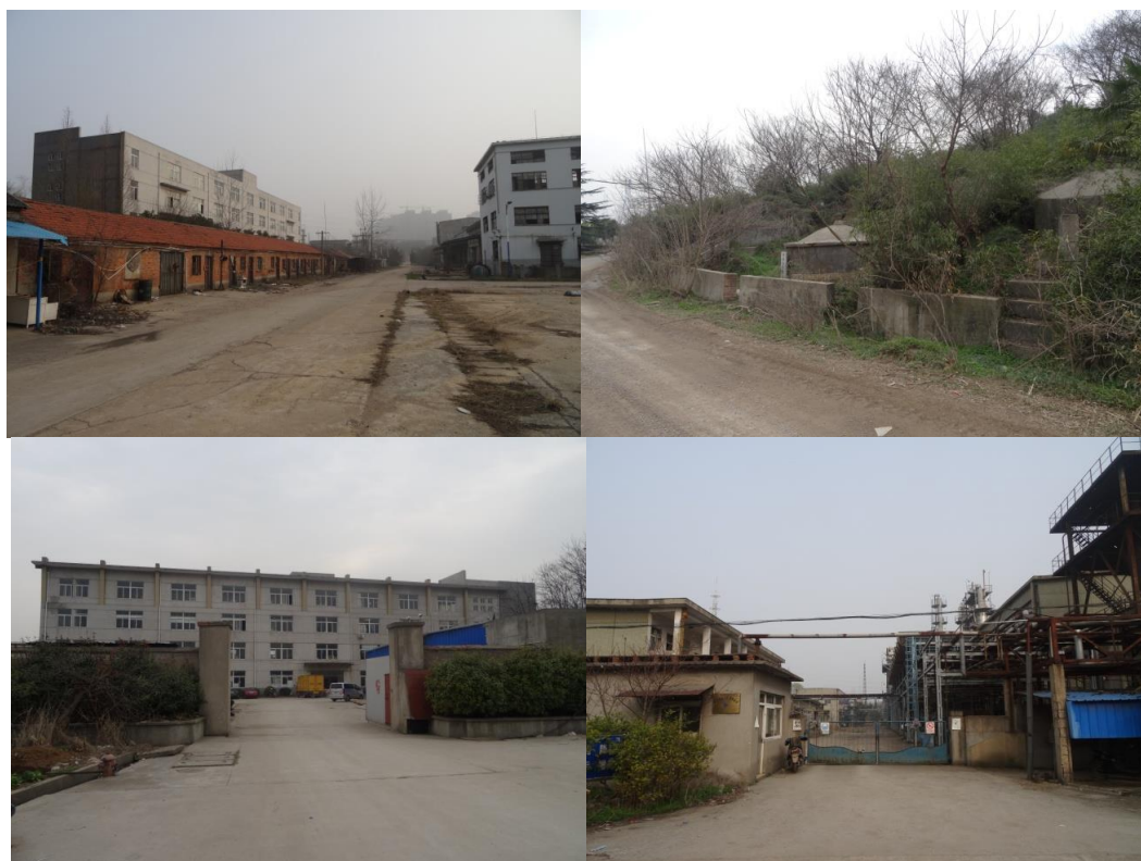
图 2.1.9-2 二桥公园停车场现状照片
