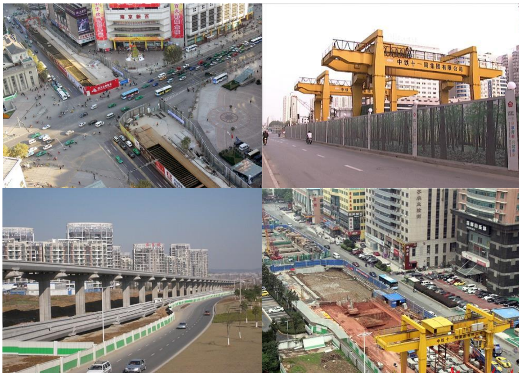
图 11.1.3-1 南京地铁施工期交通疏解现场
