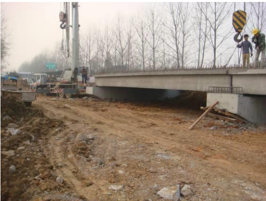
图 2.2-5 绿水湾北路下穿施工照片
