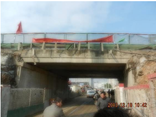
图 2.2-4 康华侨改造施工照片
