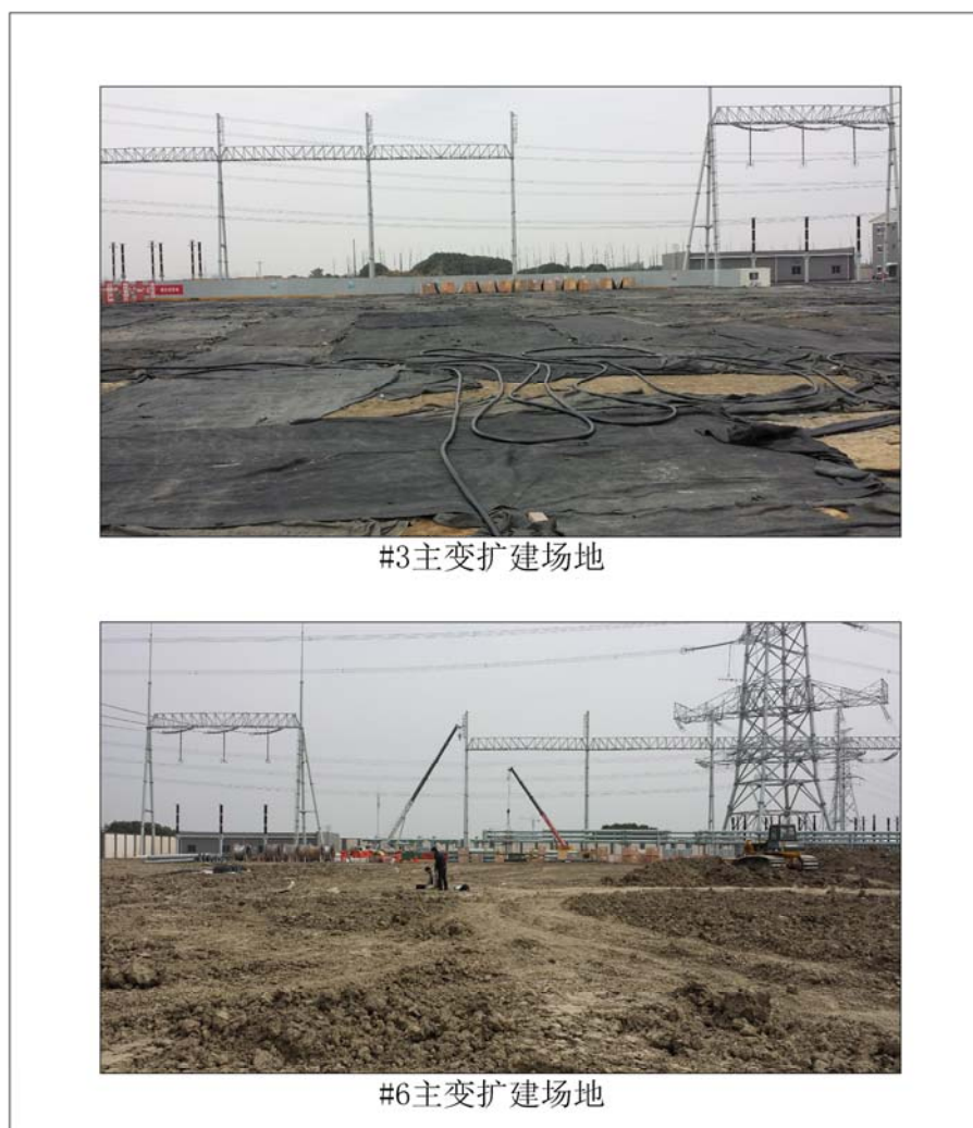
图 3.5 本工程扩建场地周围情况
