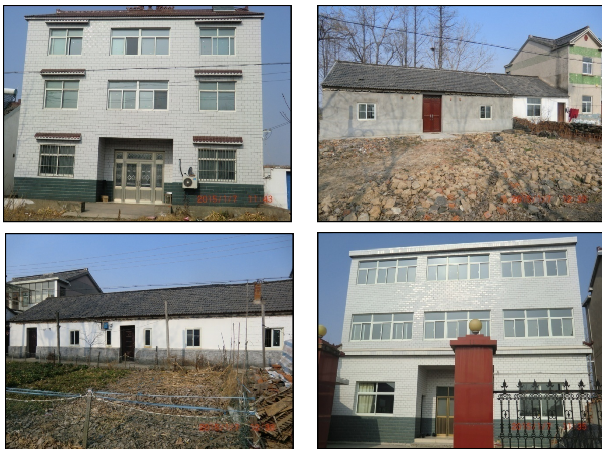
图 3.2-4 本工程隔声窗实施现状
