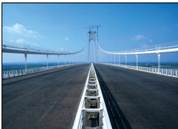
高性能可再生沥青铺装完成效果
