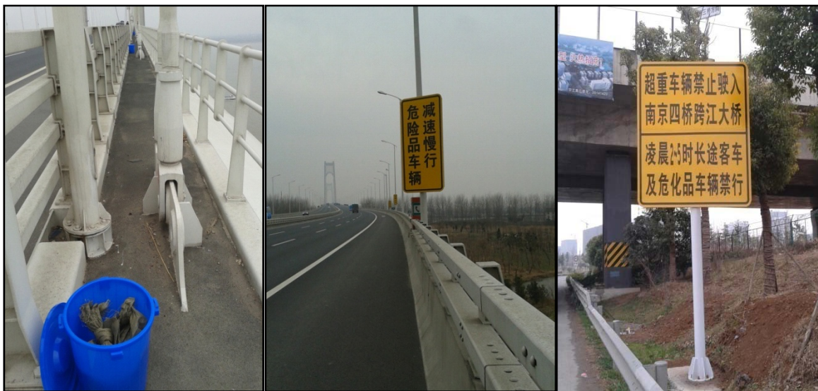
图 6.7-4 长江大桥危险品运输应急设施现状
