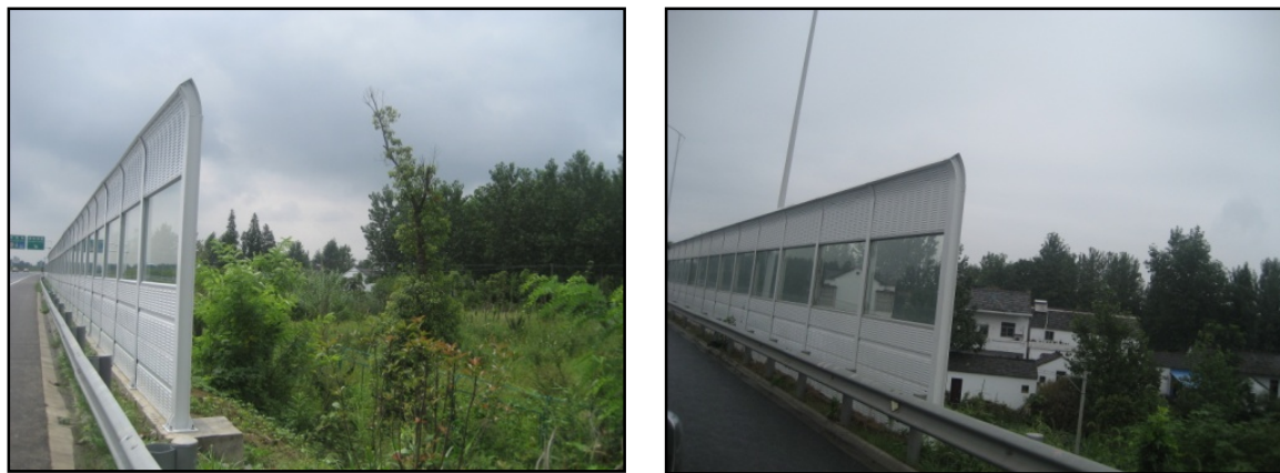
图 3.2-3 本工程声屏障现场照片
