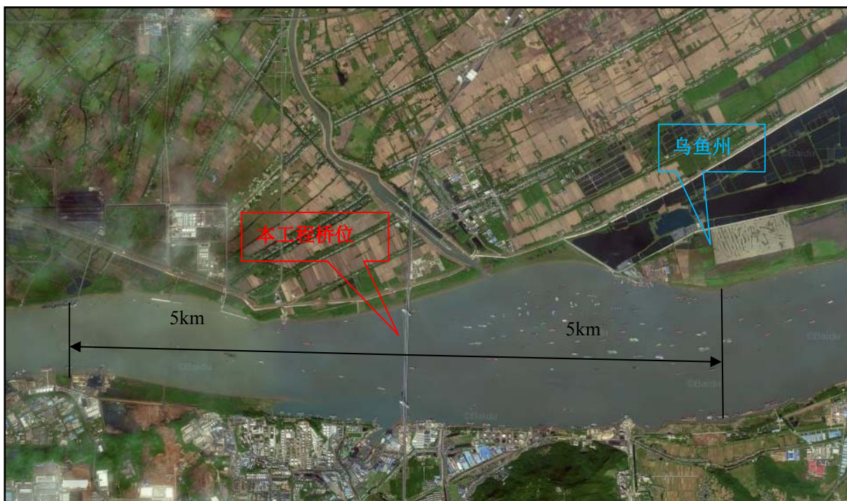
图 5.6-6 本工程桥位所处江段现状图
