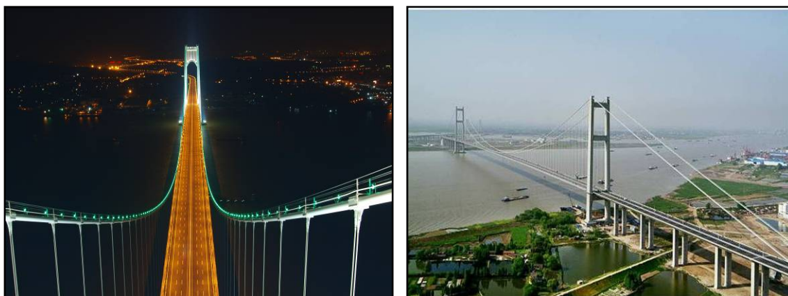
图 6.5-5 南京长江四桥桥梁景观
