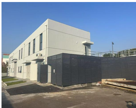
四期污水处理站
