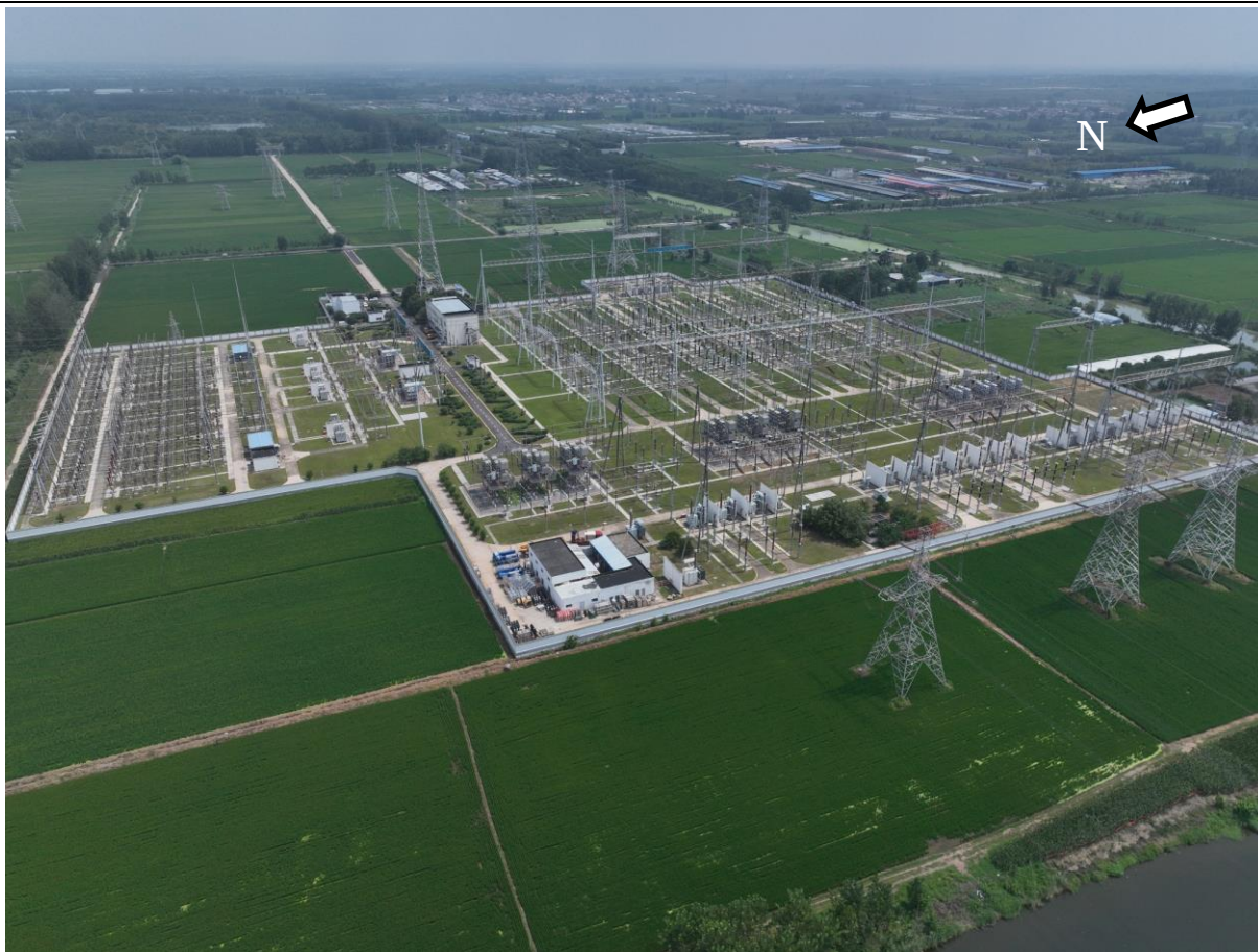
三堡变电站站址现状
