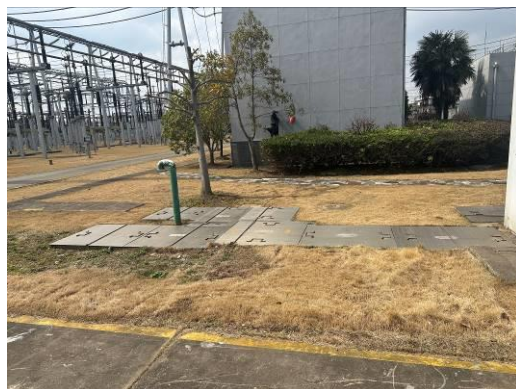
污水处理装置
