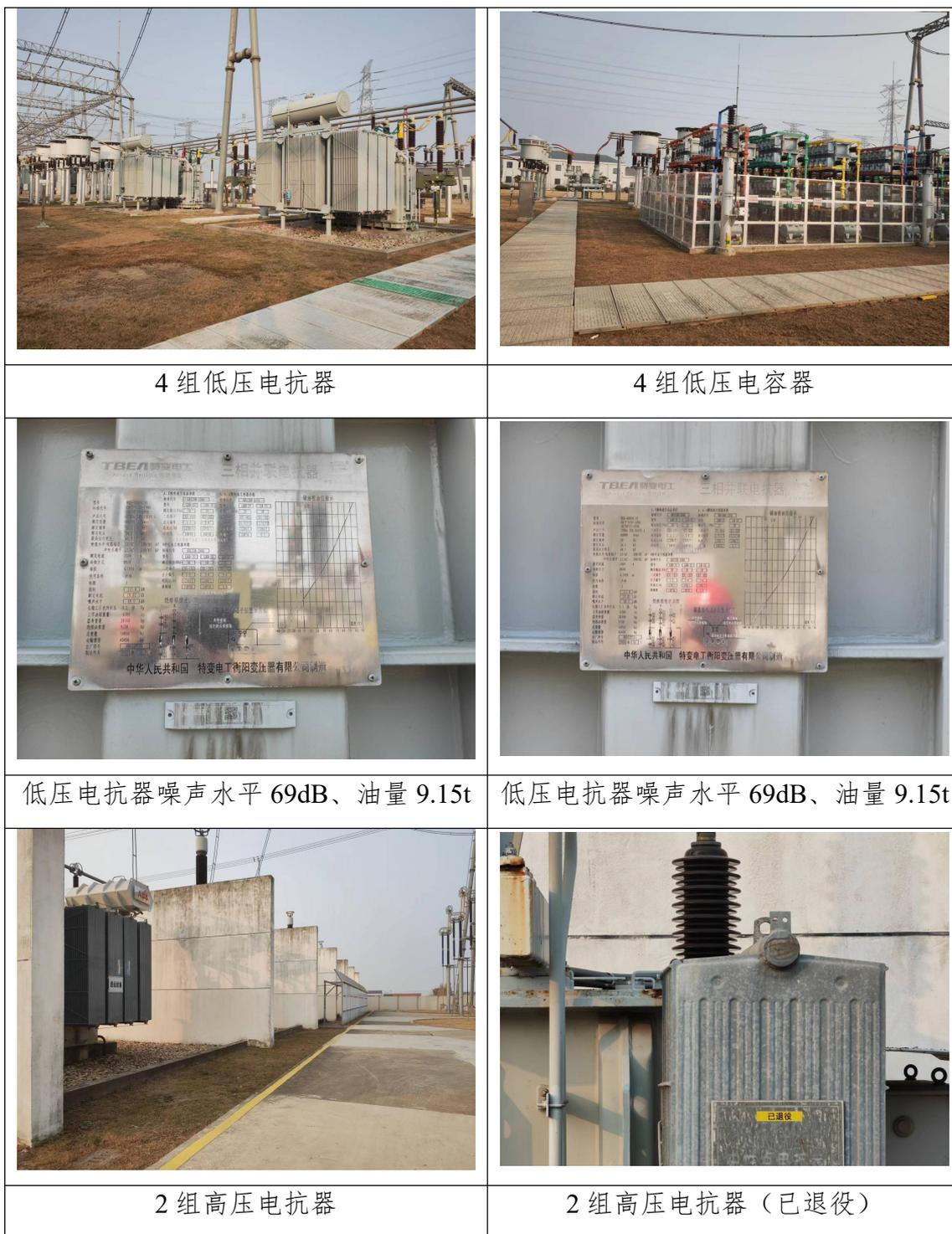
图3.14 东洲500kV变电站电气布置设备示意图
