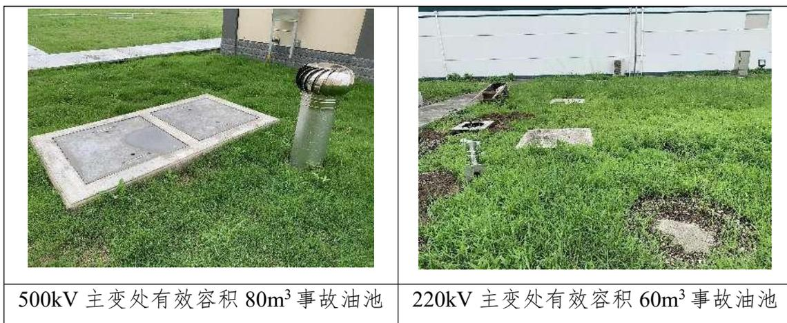
图3.9 新丰500kV变电站设置事故油情况
