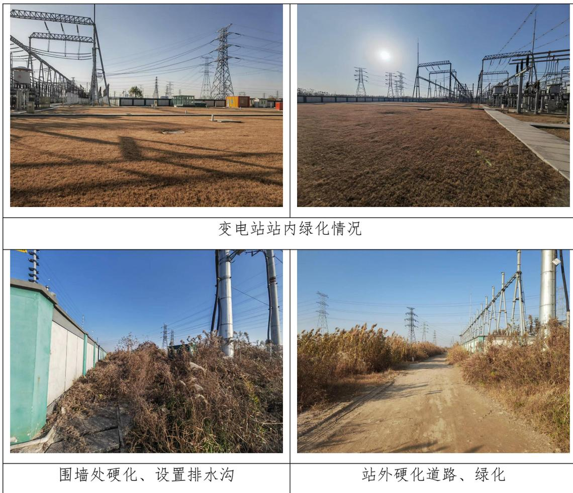
图 3.8 变电站采取生态保护措施
