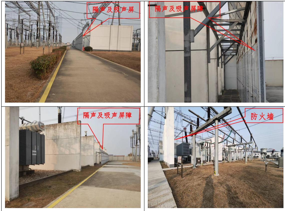
图 3.16 变电站采取噪声控制措施
