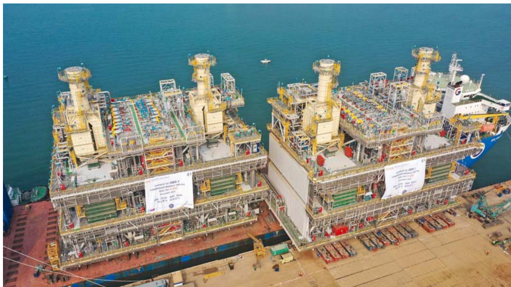
图 3.2-2 石化模块滚装装船示意图
