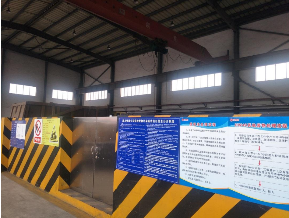
图 2.4-2 现有工程废润滑油的危废暂存间储存照片
