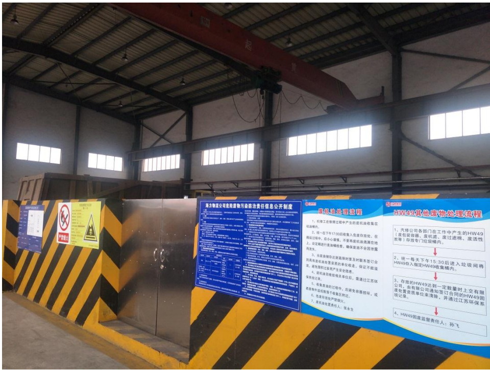
图 2.4-1 现有工程废润滑油的危废暂存间储存照片
