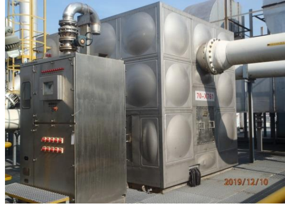
10、20、30、40 线共用分子裂解装置现状图
