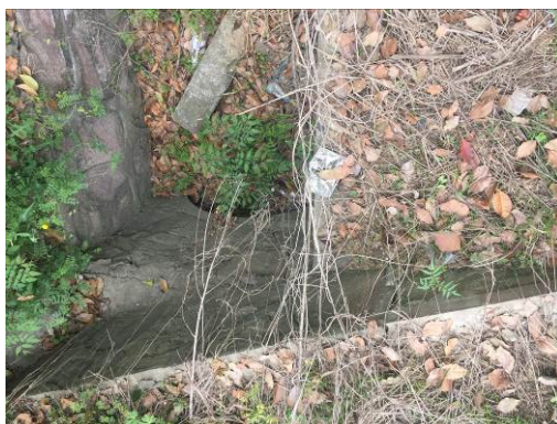
图 2.2-9 沿线涵洞现状
