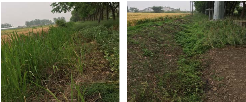
图 2.2-4 老路利用改造段土边沟
