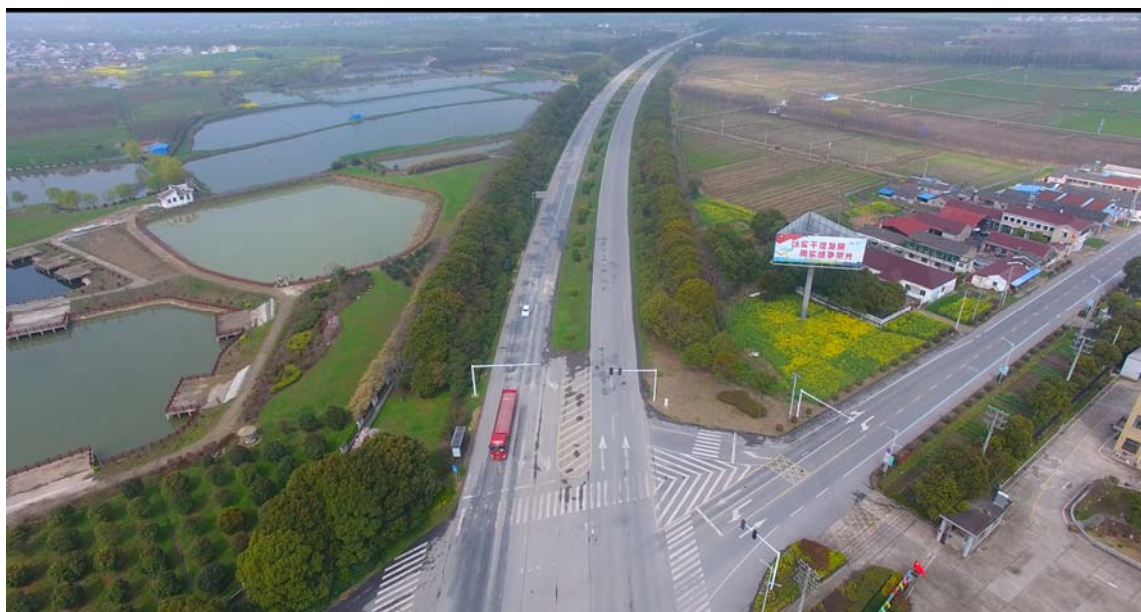
图 3.2-9 项目穿越蛟塘洪水调蓄区路段现状
