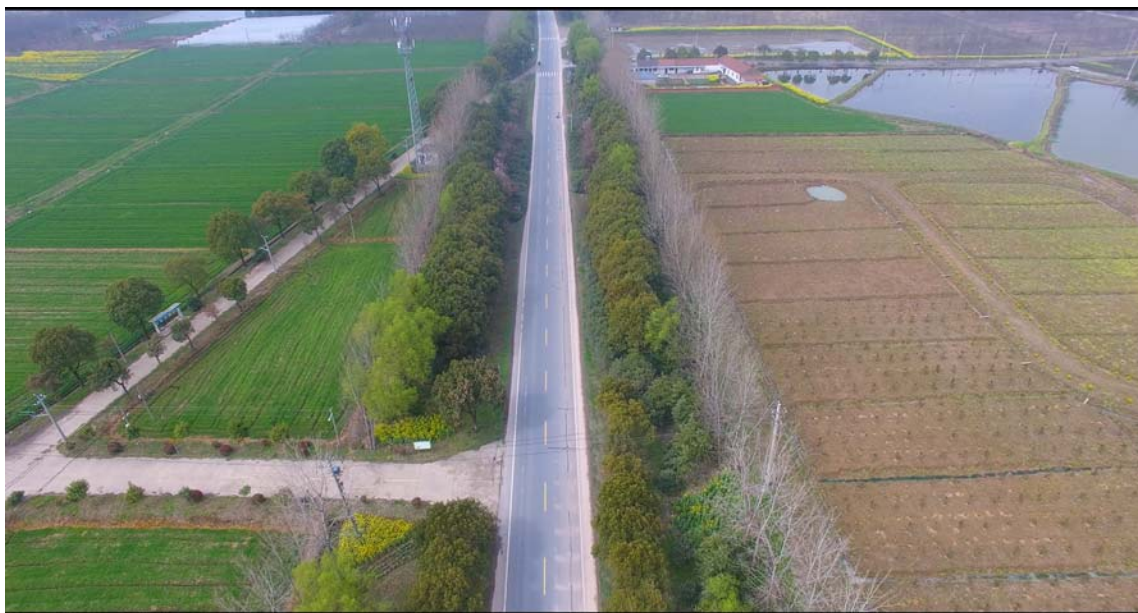
图 3.2-7 项目穿越季子庙风景名胜区路段现状
