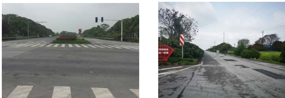
图 2.2-1 丹西公路老路现状断面
