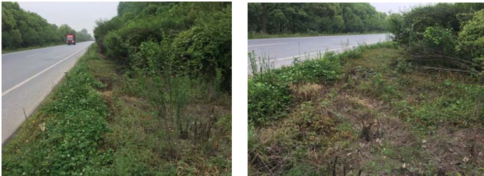
图 2.2-3 老路利用改造段边坡防护
