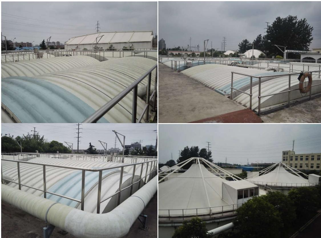
图 6.1.2-1 同类型污水处理厂装置密封效果图
