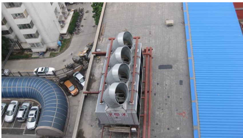
图 5.1-1 冷却塔导向消声器实施实例
