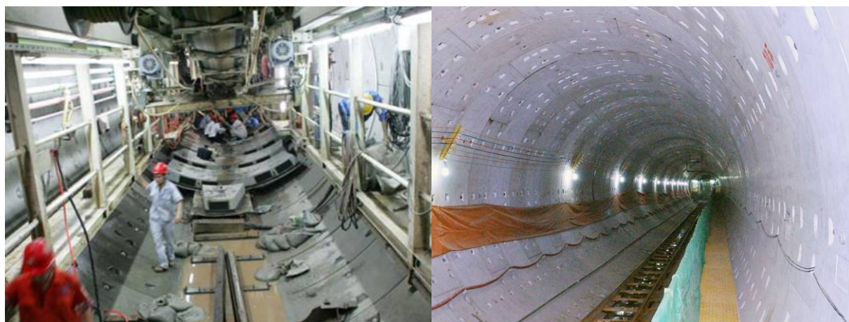
盾构法隧道内部施工现场
