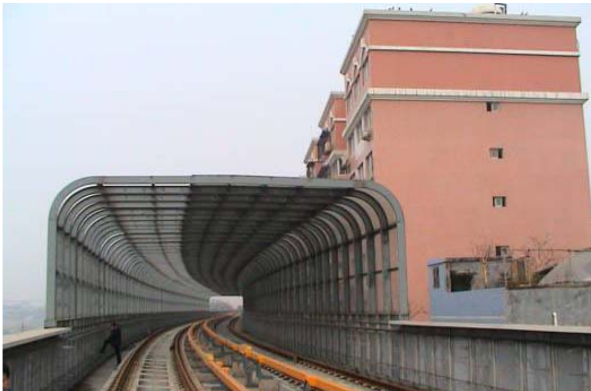
图 4.5-2 大型折板式（半封闭）声屏障示意图
