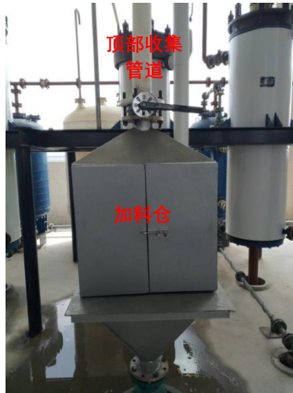
图 7.2.1-2 改建项目加料系统及粉尘收集管道图
