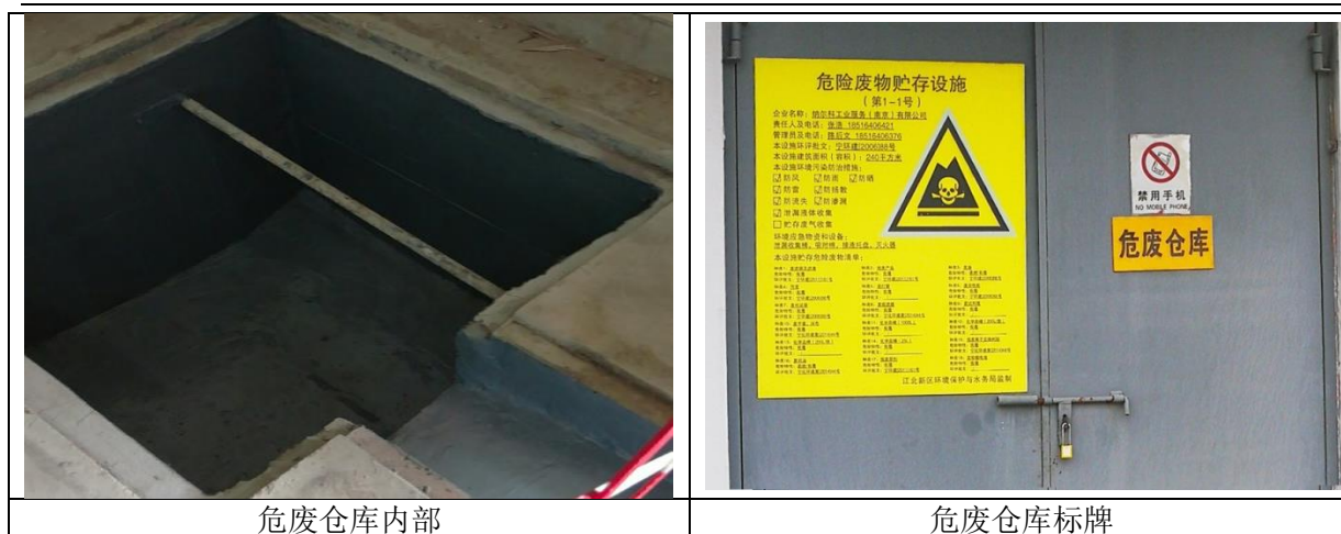
图 9.1-3 危险废物堆场
