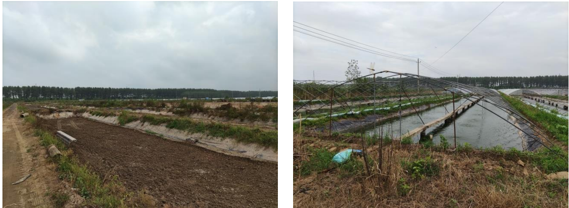
图 3.1-1 丰海 500kV 变电站站区现状
