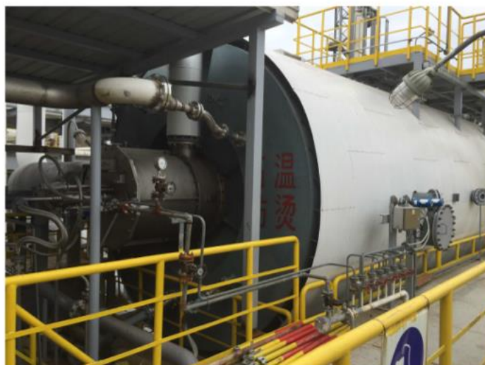
图 7.1-2 宁波万华同类型焚烧废液炉
