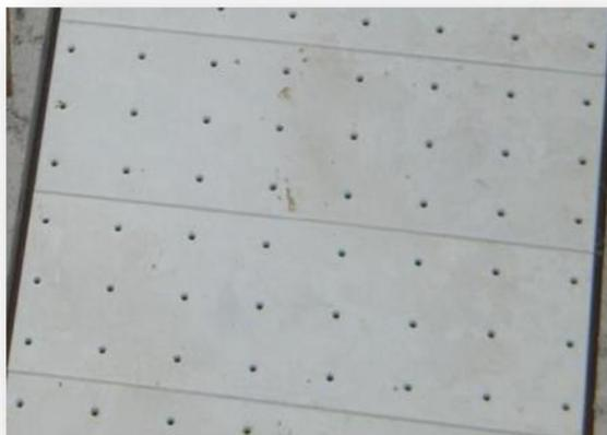
图 4-3-4 整体浇筑滤板之模板
