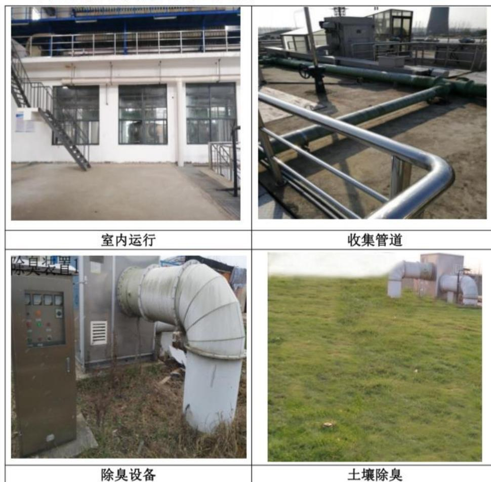
本工程采用土壤生物滤池技术。在产生臭气的构筑物加罩方式进行封闭，并通过抽风机将罩内的臭源等异味引至生物填料除臭装置进行除臭处理。根据需除臭构筑物的位置，以及风管的布置方式，拟分组布置除臭设备，共分 2 组，进水泵房前粗格栅间、细格栅及曝气沉砂池为 1 组，布置 1 套土壤生物滤池脱臭设备及风管；污泥浓缩脱水机房除臭为一组，布置 1 套土壤生物滤池脱臭设备及风管。废气经处理后可达到《恶臭污染物排放标准》（GB14554-93）的排放要求。
