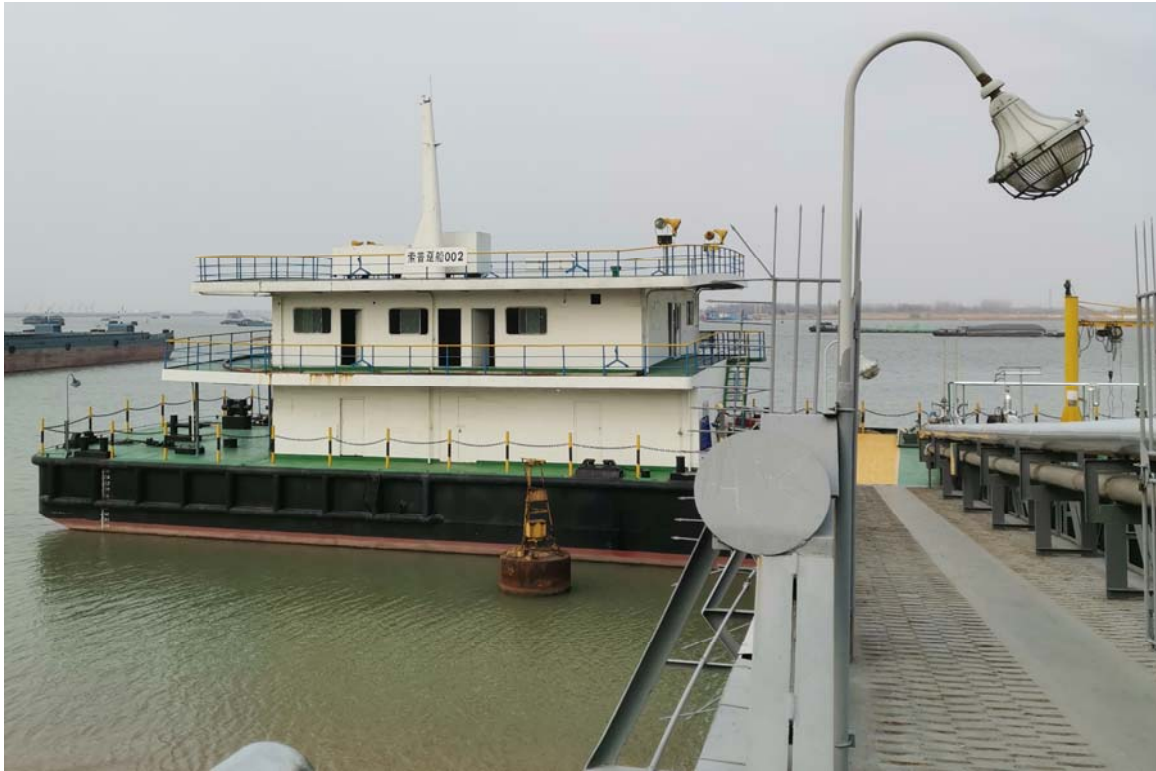
图 3.3-1 趸船码头现场照片
