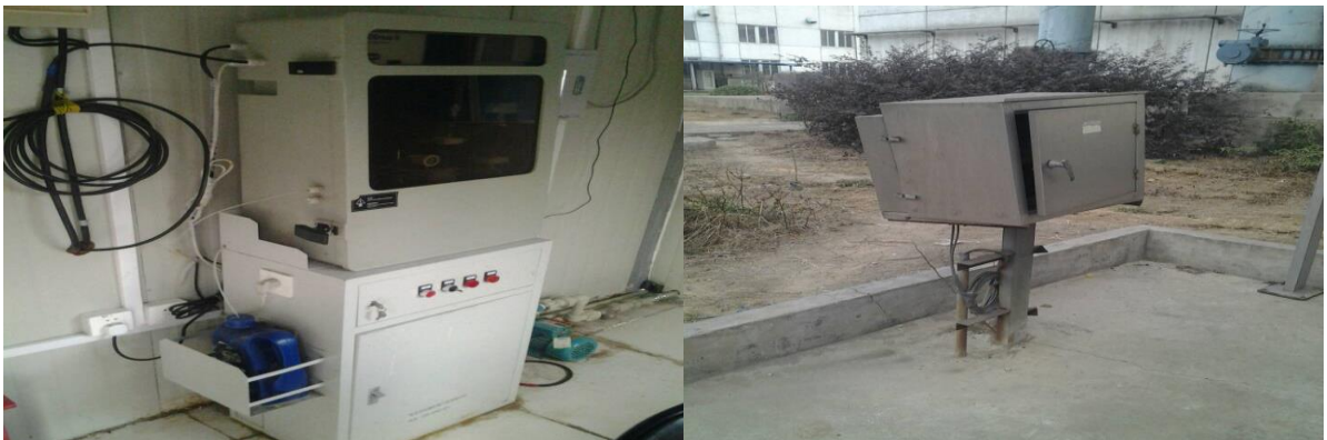
图 3.1-1 雨水排放口 COD 在线监测设备及流量计
