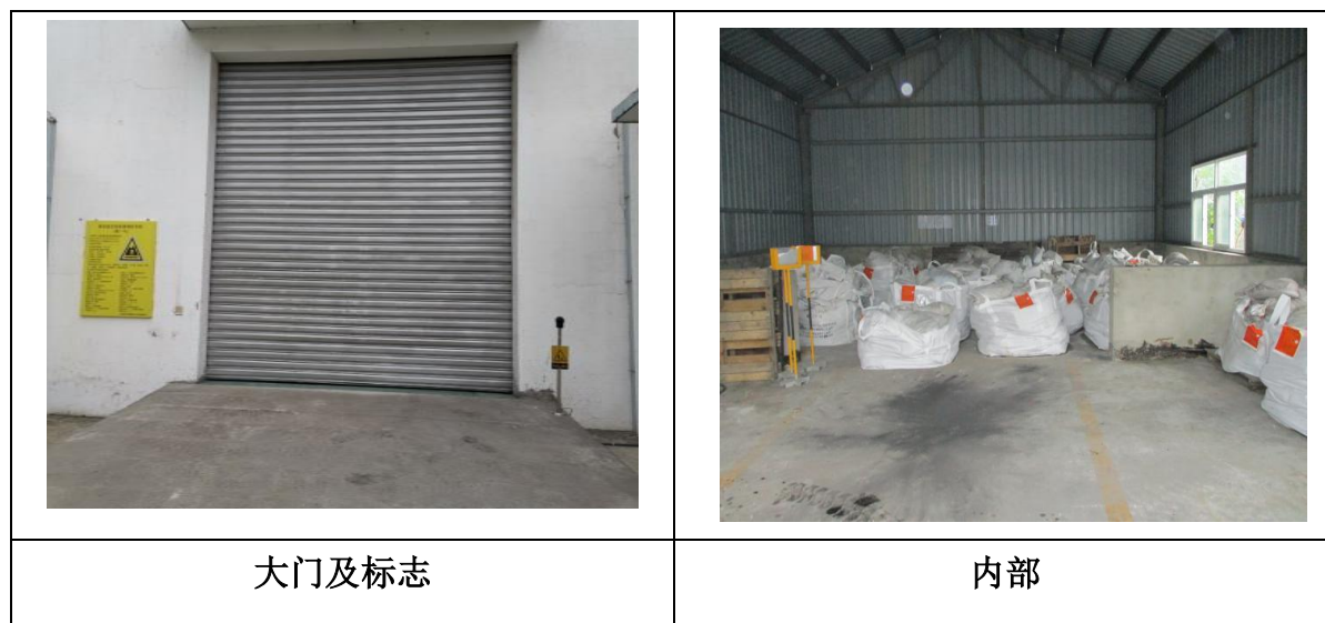
图 9.1-4 危险废物仓库
