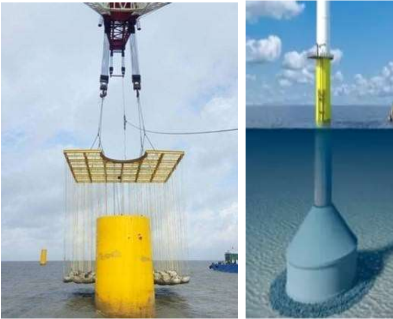
图 3.4-6 基础防冲刷保护
