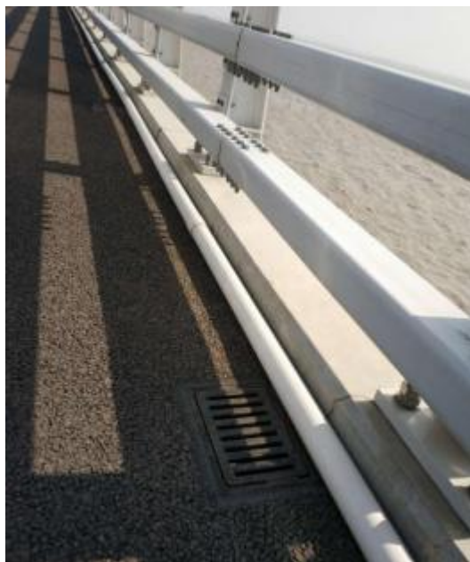
图 7.3-1 大桥集水槽照片
