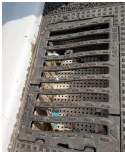
图 7.3-2 集水槽照片（尚添加过滤体）
