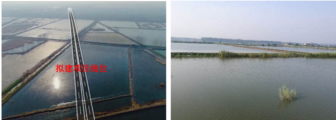
图 3.2-8 西塘河重要湿地圩区现状照片
