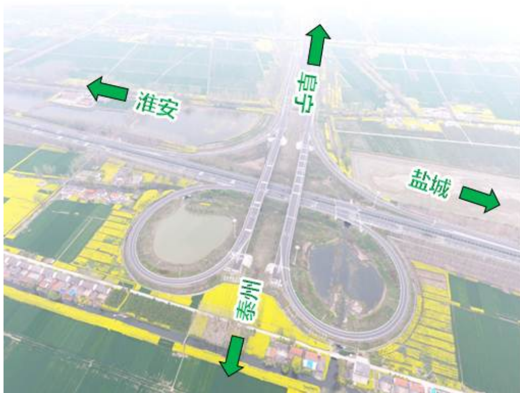
图 2.3-9 九龙口枢纽现状
