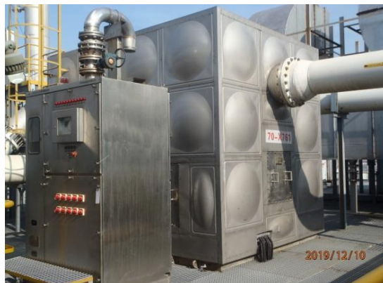
10、20、30、40 线共用分子裂解装置现状图
