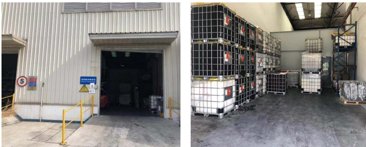
图 3.5-3 现有项目危险废物仓库照片
